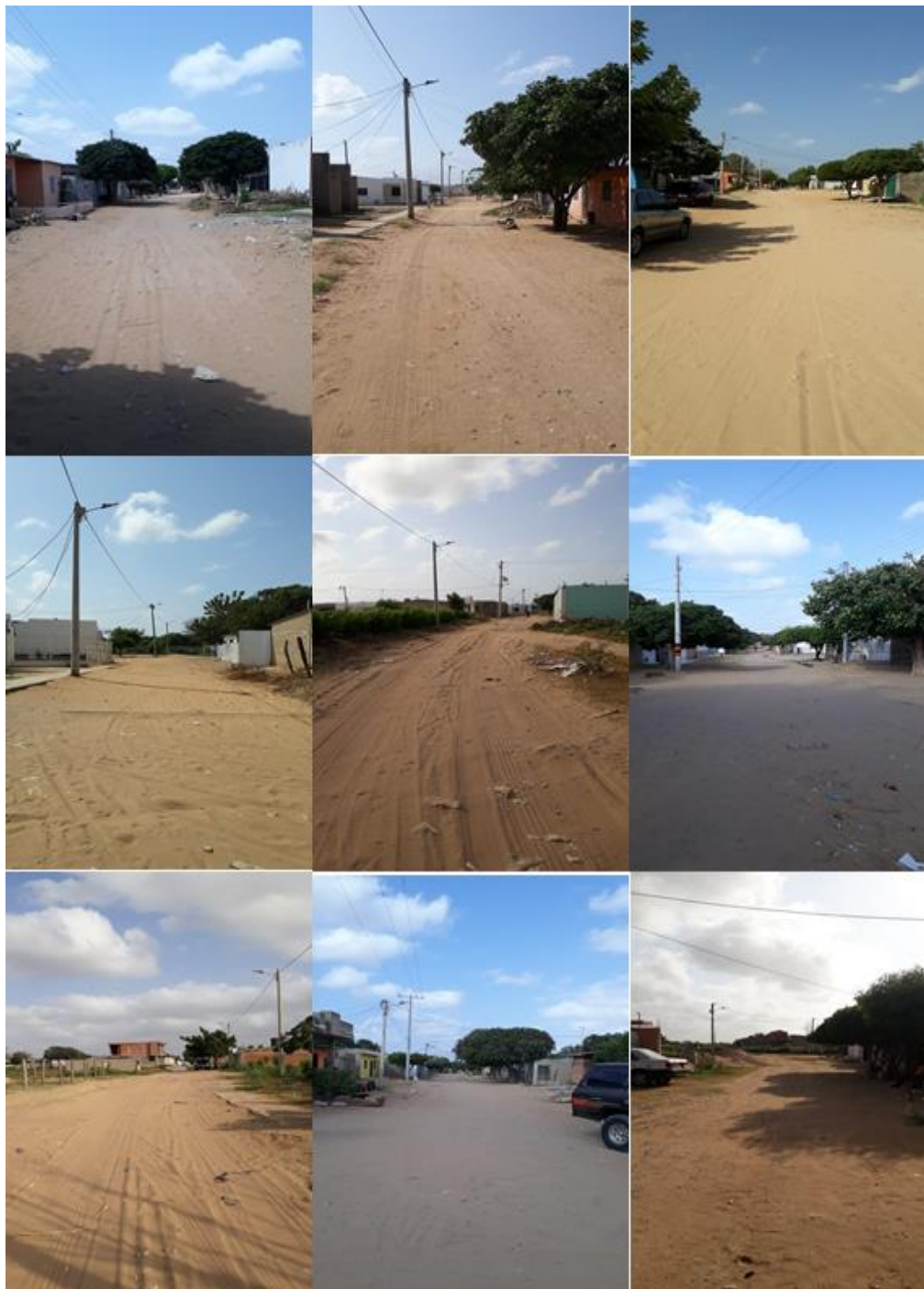
Ilustración 2: Memoria fotografía estado actual de la vía. Fuente: Propia
