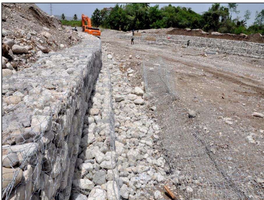
Ilustración 5 Disposición de los Gaviones (1)
