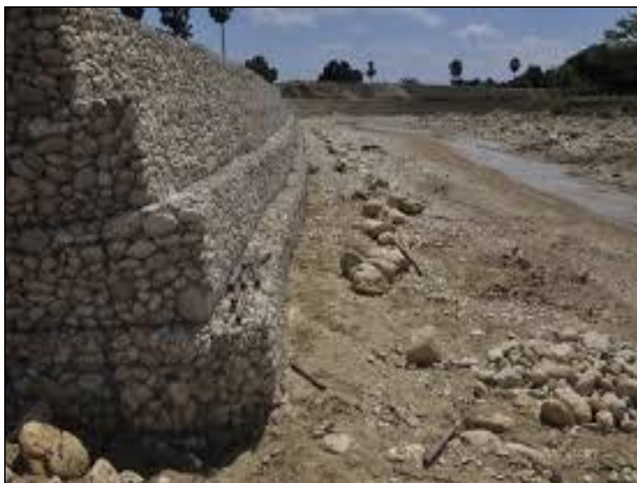
Ilustración 6 Disposición de los Gaviones (2)
